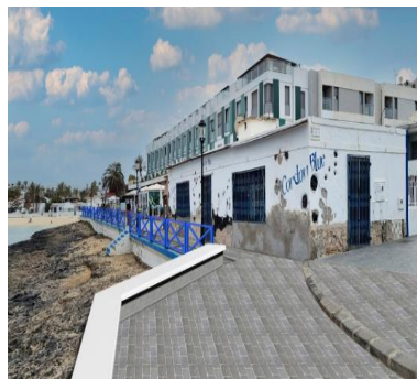
Pavimentación paseo Corralejo. Tramo: Muelle Chico – Hoplaco
