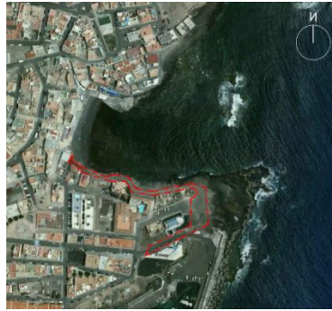
Intervención en el espacio público de El Cotillo – frente marítimo, fase II
